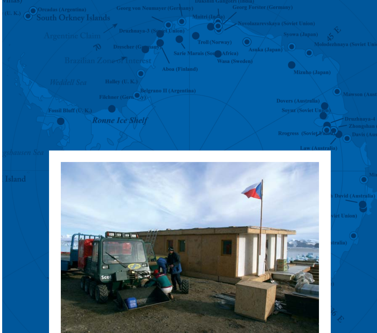
VÝSTAVBA ČESKÉ POLÁRNÍ STANICE NA OSTROVĚ JAMESE ROSSE ZE SYSTÉMU K-KONTROL®
