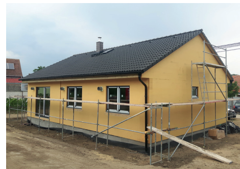
Hrubá stavba při předání
