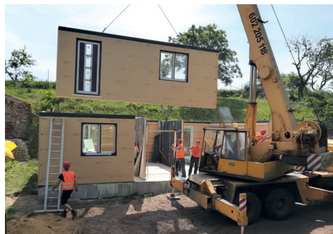
Montáž hrubé stavby
